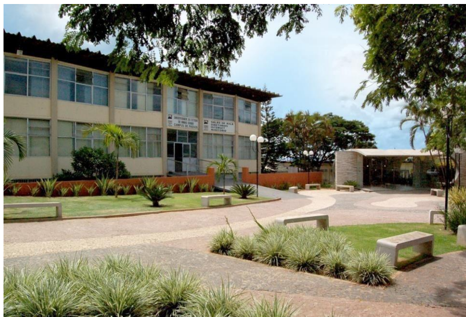
Figura 8: Área externa e fachada
