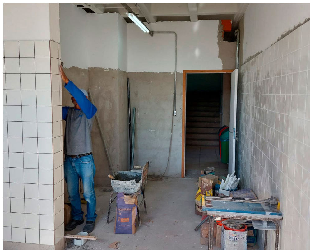
Colocação de ladrilhos. Foto: Christian Fuentes
